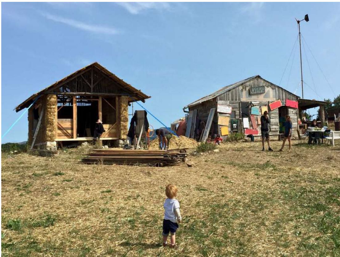
The Amassada Commune Libre, against RTE's Transformer. Saint-Victor-et-Melieu (Aveyron)
